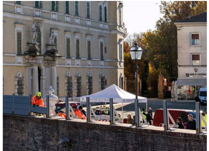
Bild 1 Geprüftes L-System zur Erhöhung einer Ufermauer
