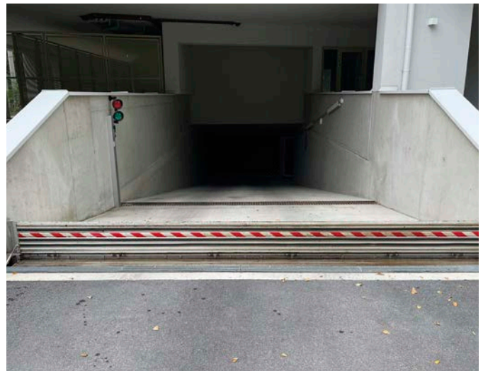
Bild 2 Geprüftes O5-System (selbstschließende Klappe)
